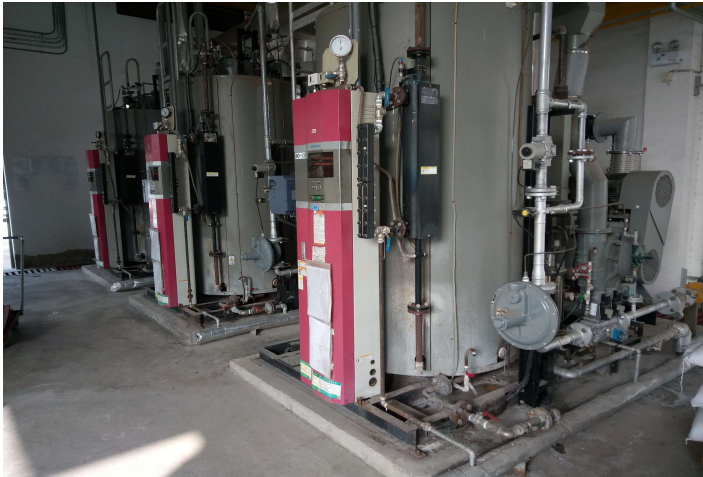
燃气锅炉低氮改造
