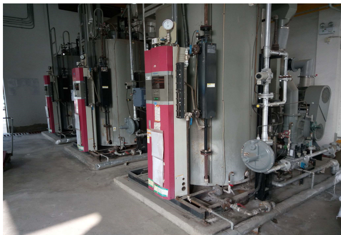
燃气锅炉低氮改造
