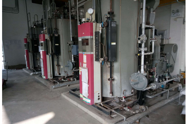
燃气锅炉低氮改造
