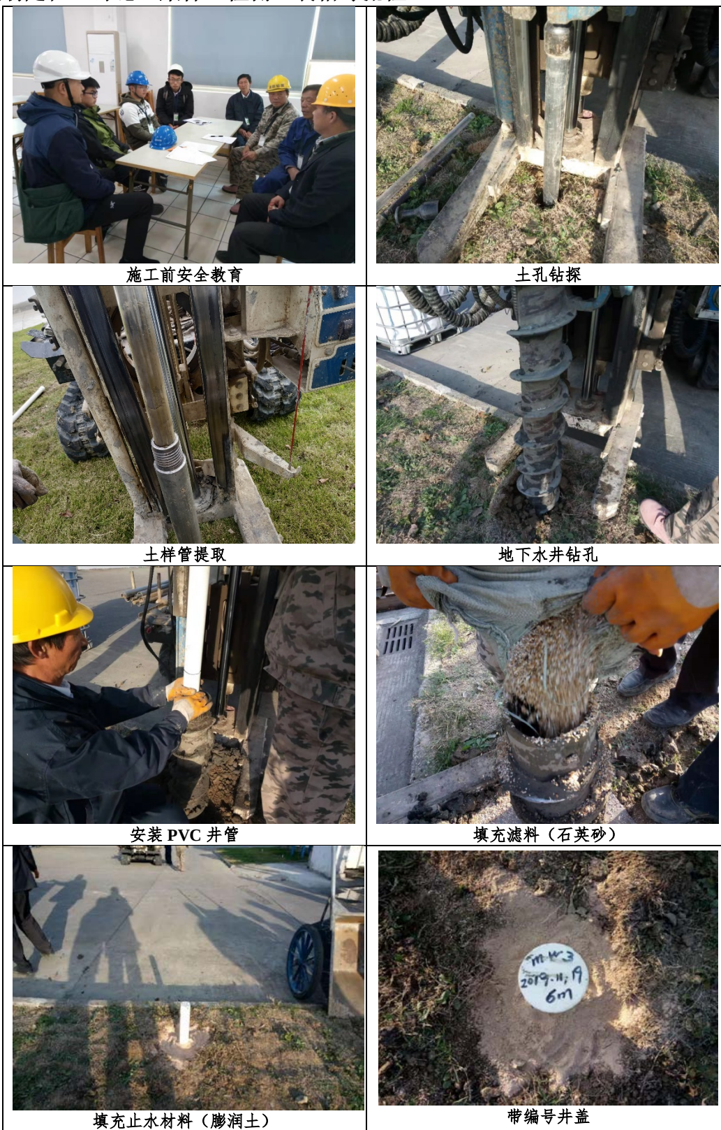
附图 4：现场采样过程照片记录（瑞环（苏州）环境有限公司） 现场定位、讨论、采样、检测、装箱等流程
