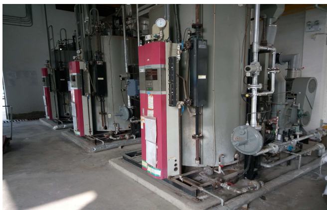
燃气锅炉低氮改造
